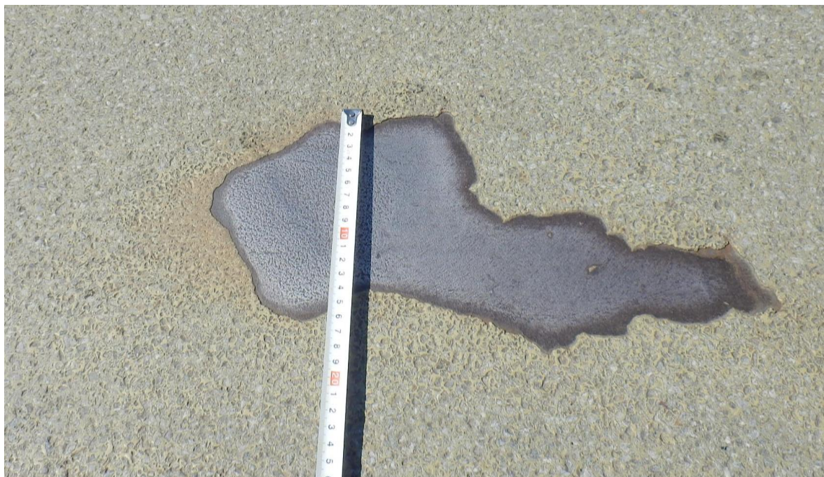
Att. Nr. 6. Tilta paceļamās daļas seguma raksturīgie defekti
