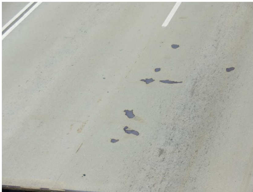
Att. Nr. 6. Tilta paceļamās daļas seguma raksturīgie defekti
