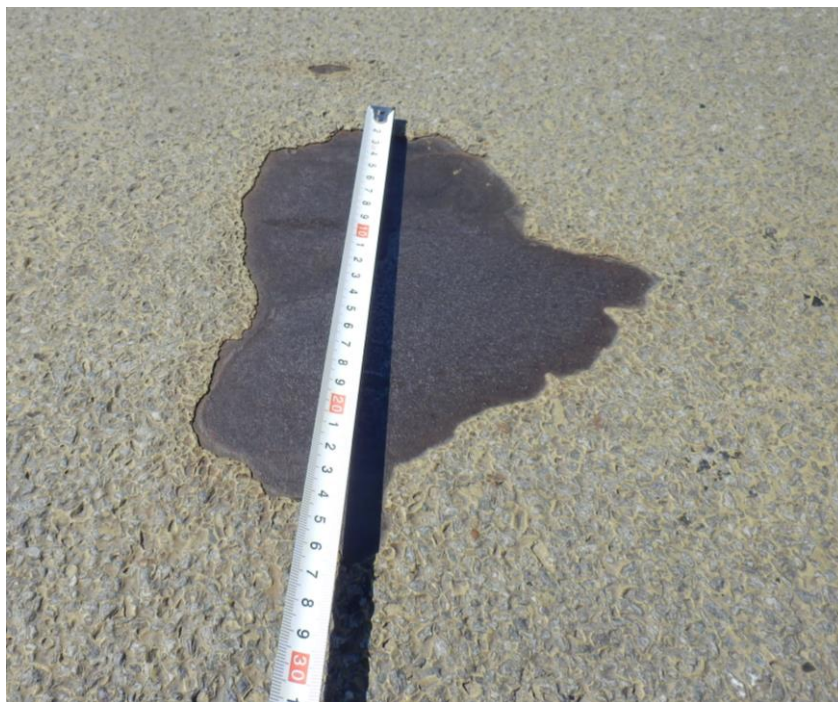
Att. Nr. 8. Tilta paceļamās daļas seguma raksturīgie defekti
